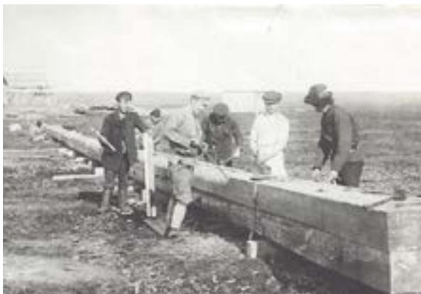
Предварительная сборка мачты радио-телеграфа. ГАНУ. Ф.Р-271. Оп.1. Д.4. Л.141
