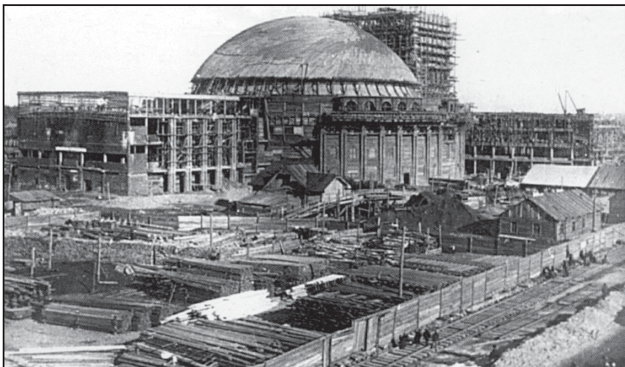
Строительство театра оперы и балета, 1935 г.
